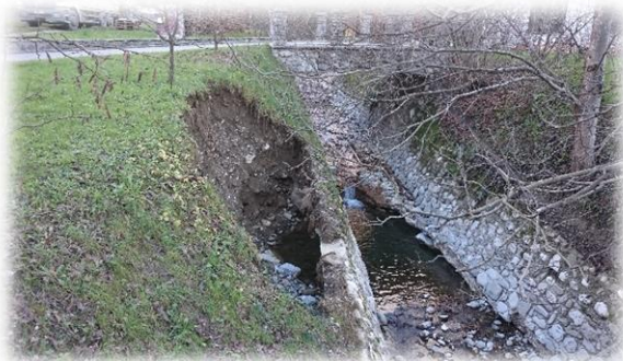
Slika 27: Erozija brežine Idrija pri Bači (levo) in porušitev premostitve Naselje Sv. Barbara (desno) (Jakopič B., 2014)
