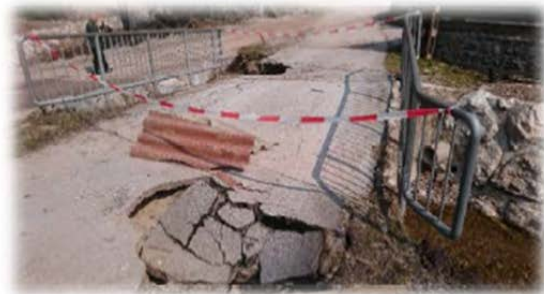
Slika 24: Erozija brežine Idrija pri Bači (levo) in porušitev premostitve Naselje Sv. Barbara (desno)
