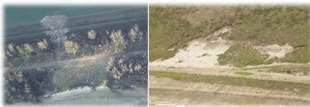
Slika 27: : Delna porušitev nasipa z nepoškodovano krono (levo) in precejanje skozi vklop (desno) (DEM, 2012)
