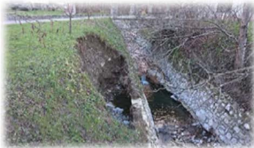
Slika 24: Erozija brežine Idrija pri Bači (levo) in porušitev premostitve Naselje Sv. Barbara (desno)
