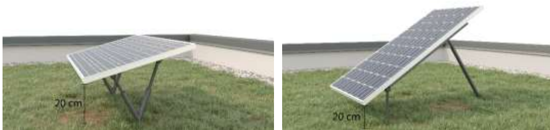
Slika 15: Primer postavitve fotonapetostnega modula na ozelenjeno streho
