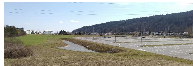
Infiltracijska kotanja na P+R parkirišču v Stanežičah.
