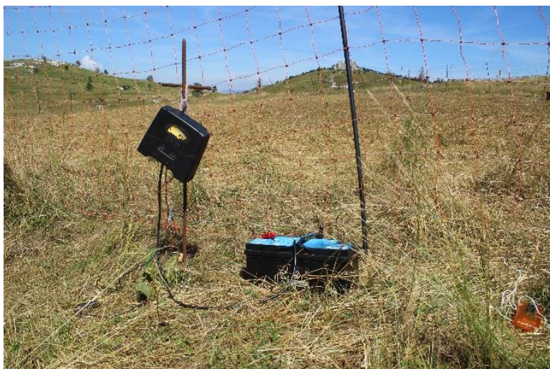
Slika 4: Zaraščena trasa elektromreže. Rastline, ki se dotikajo žic, odvajajo tok v zemljo, s tem pa električna napetost pada.
