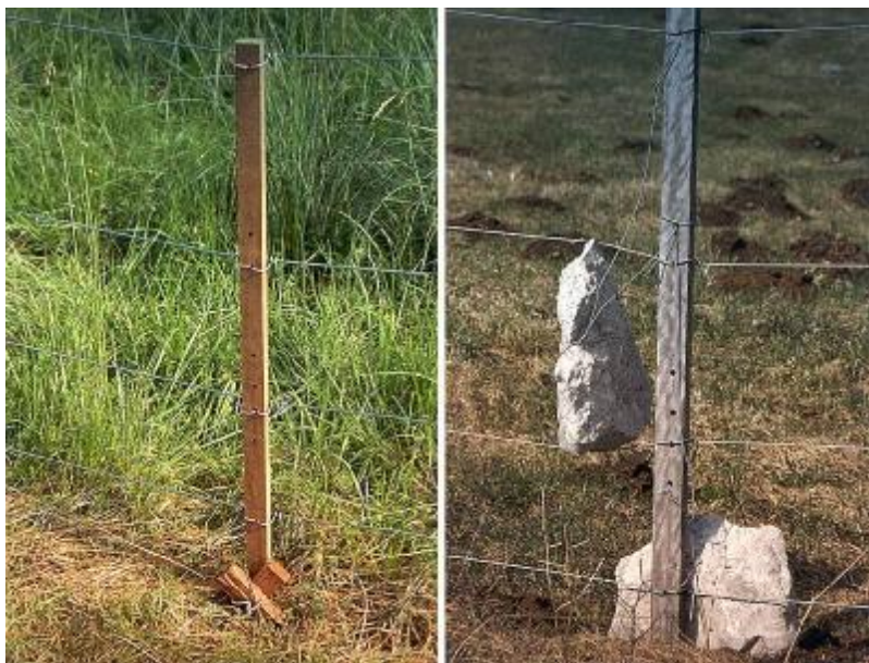
Slika: V kotanji je treba distančnik privezati na sidro zabito v zemljo (levo) ali ga obtežiti z dovolj težko skalo (desno).
