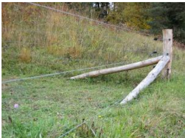
Slika: Opaznost stalne večžične elektroograje dosežemo z pocinkano žico ustrezne debeline in lesenimi koli.
