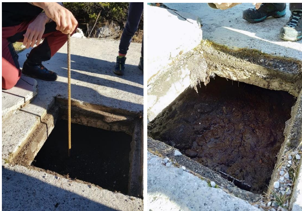
Slika 17: Prvi prekat južnega usedalnika (točka B), 21. 11. 2021, je popolnoma napolnjen z blatom.
