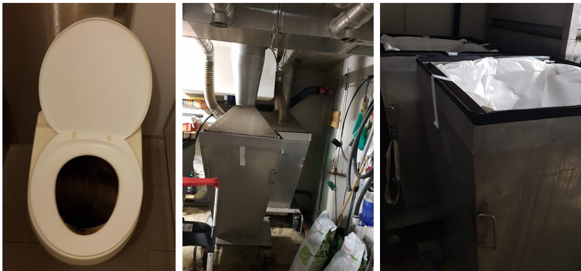
Slika 4: Suha stranišče (levo), zbirna enota v kleti pod straniščem (sredina) in prazna zbirna vreča v kovinskem nosilcu (desno).
