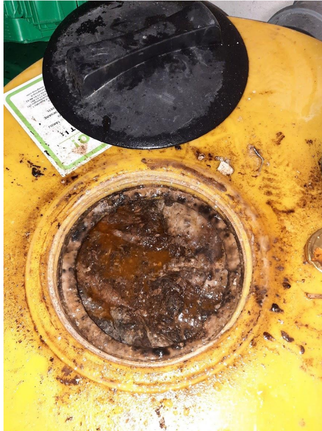
Slika 15: Povsem napolnjen lovilca maščob, 8.9.2021. Dva prazna lovilca maščob na voljo v kleti.
