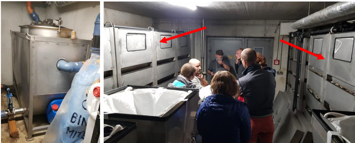
Slika 3: Lovilec maščob (levo) in več enot precejalnika sive vode (desno, označeno s puščicami) v kletnih prostorih koč.
