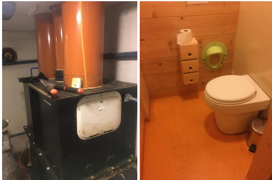
Slika 8: Predelovalna komora za kompostiranje (levo) in suho kompostno stranišče (desno) – Glocknitzer Hut, Austria.
