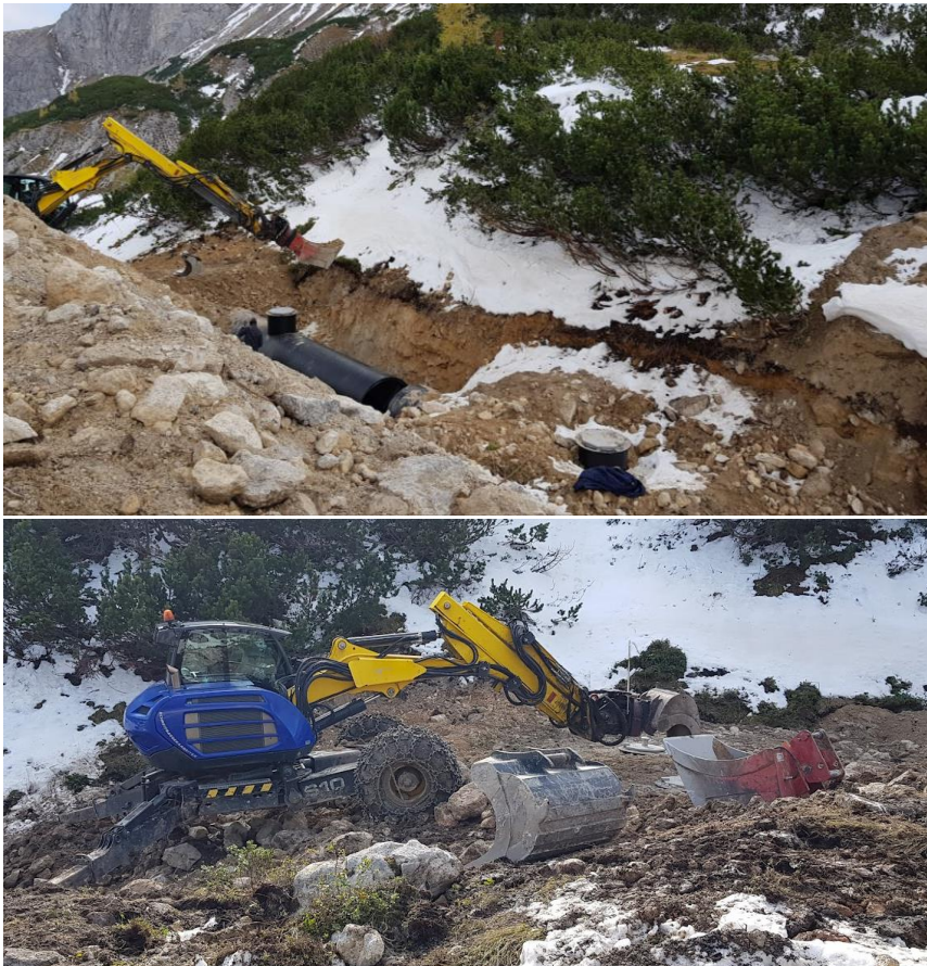
Slika 5: Vgradnja podzemnega zadrževalnika za pitno vodo pri koči Voisthaler.
