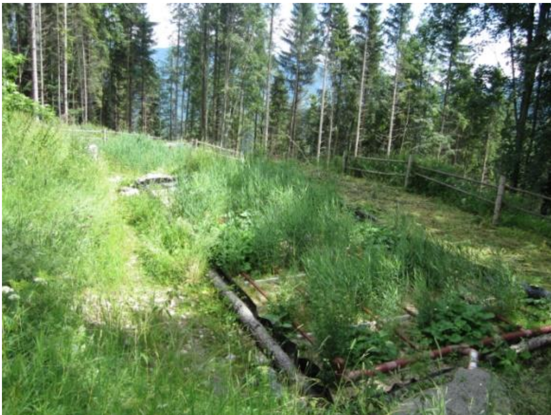
Slika 19: Primer rastlinske čistilne naprave zasajene z navadnim trstom ( Phragmites australis ).
