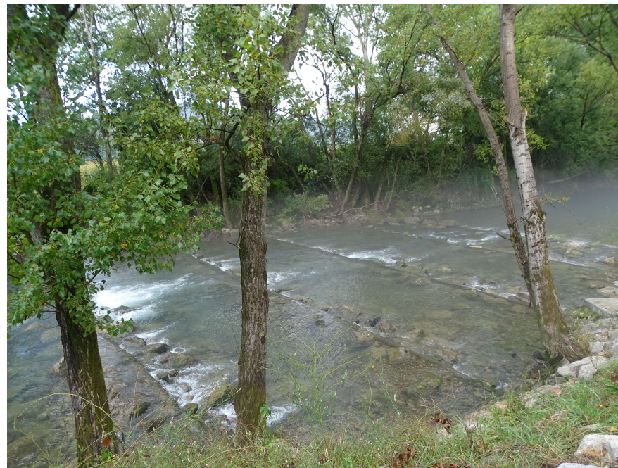
Izvedba drče za ribe – vzpostavitev prehodnosti odseka Vipave, projekt VIPava (Foto: Jana Laganis ZRSVN)
