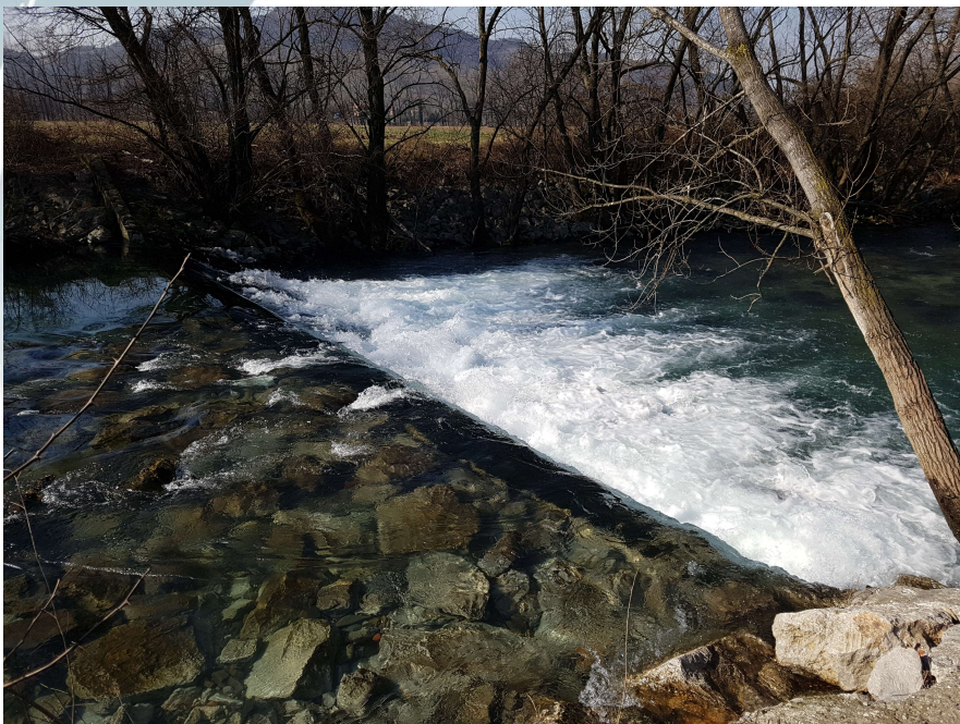
Izvedba drče za ribe – vzpostavitev prehodnosti odseka Vipave, projekt VIPava (Foto: Jana Laganis ZRSVN)
