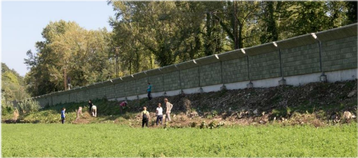
Slika 21: Odstranjevanje »preproge« rastlin kudzuja, ki so gosto prekrivale brežino pod požarnim zidom (1. dan odstranjevanja).
