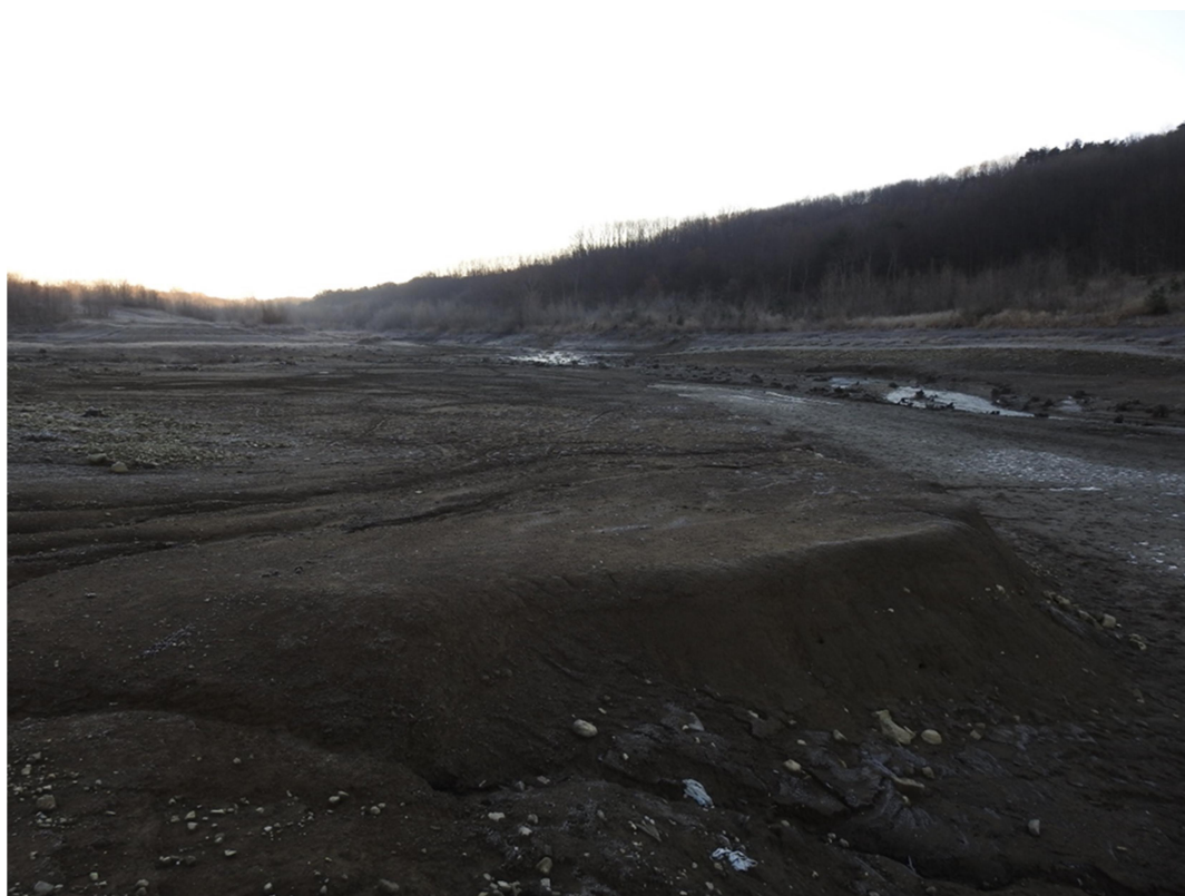
Slika 38: Terenski ogled po praznjenju akumulacije Vogršček dne 14. 12. 2020 (Foto: Tomaž Remžgar).
