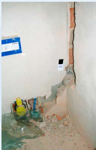
Utor je prekinil navpično armirano betonsko zidno vez.
