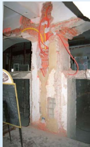
Obsežni utori za novo inštalacijo so nevarno oslabili konstrukcijo na zelo obremenjenem mestu.
