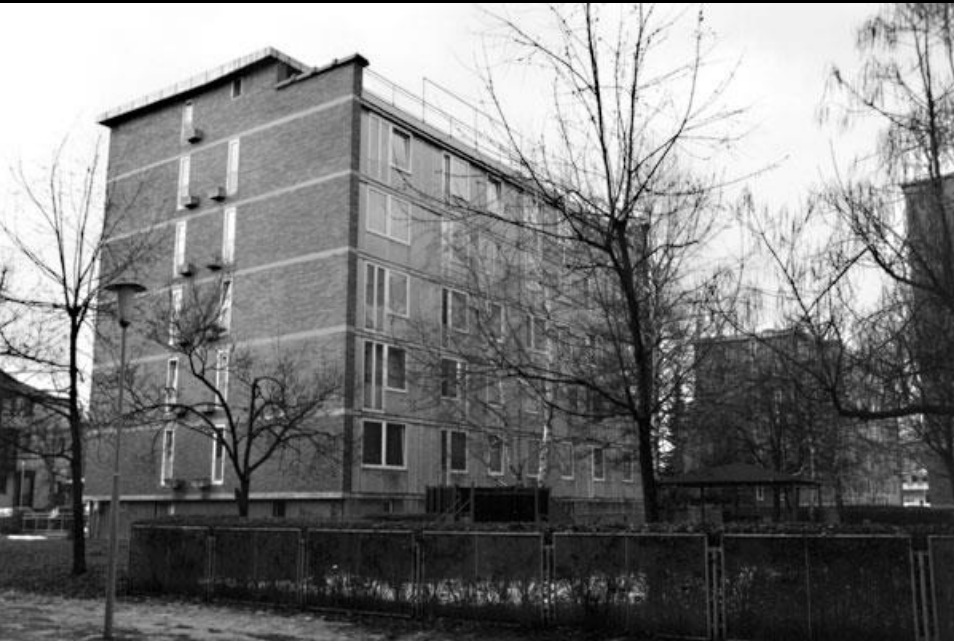
PROBLEMATIKA ENRGETSKE SANACIJE NASELIJ / GLAVARJEVA / FURST
