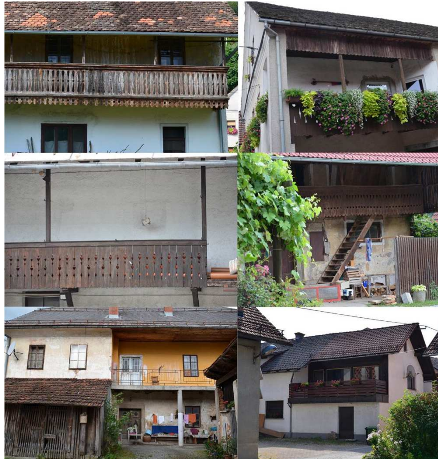
Leseni ganki z rezljano ograjo na (1) hiši na Paplerjevi 1, (2) Kosovi hiši na Zalarjevi 12, (3) gospodarskem poslopju na Paplerjevi 6, (4) gospodarskem poslopju na Rimski 34. (5) Na ganku stare pošte na Rimski 28 manjka značilna lesena ograja, zato izgleda kot še en navaden balkon. (6) Iz ganka na hiši na Paplerjevi 2 je nastal balkon s sodobno leseno ograjo z vodoravnimi deskami.
