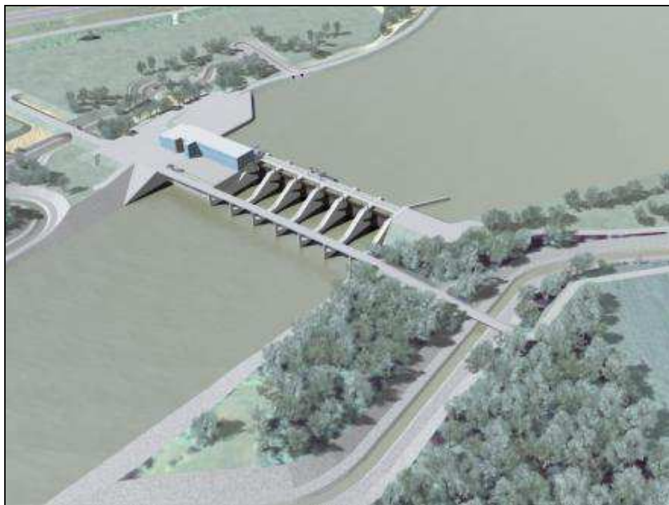
Slika 5: Simbolični prikaz ureditve preko stebrov prelivnih polj
