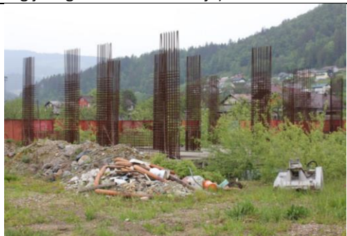
Območje opuščene gradbišča Prisoja 2 (Radlje ob Dravi, Koroška statistična regija)
