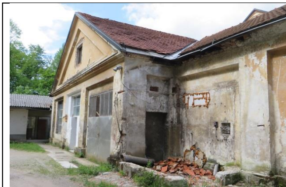
Opuščena vodarna-elektrarna Kočevje (Kočevje, statistična regija Jugovzhodna Slovenija)
