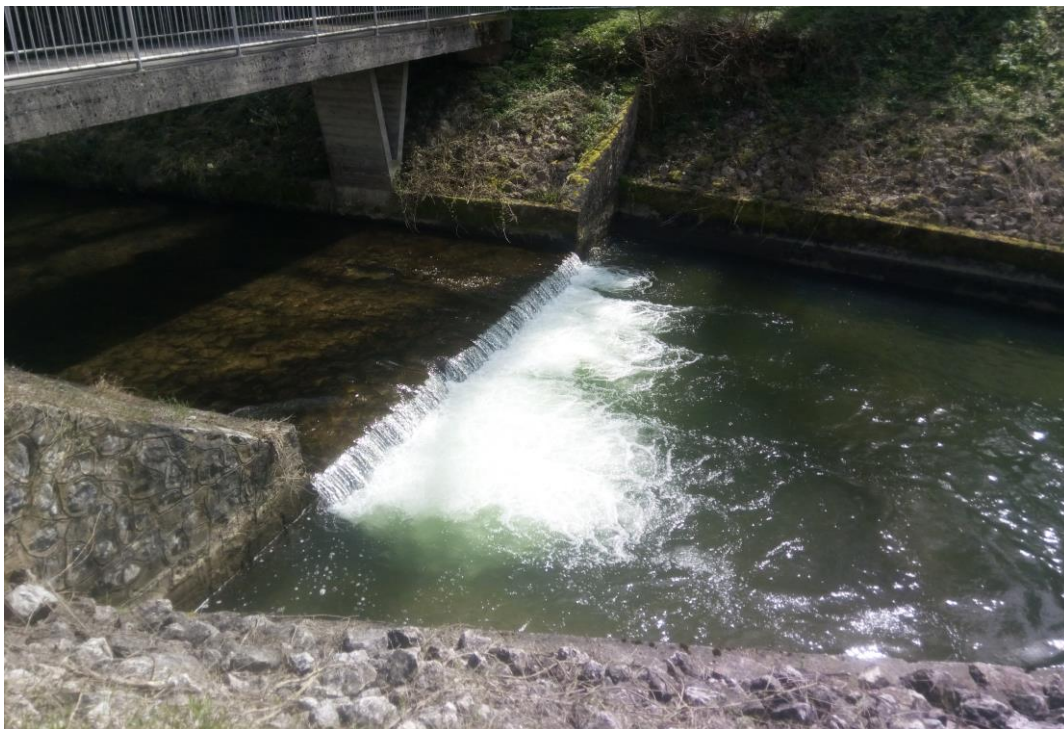
Slika 5: Neprehodna pregrada na Brestanici v kraju Brestanica
