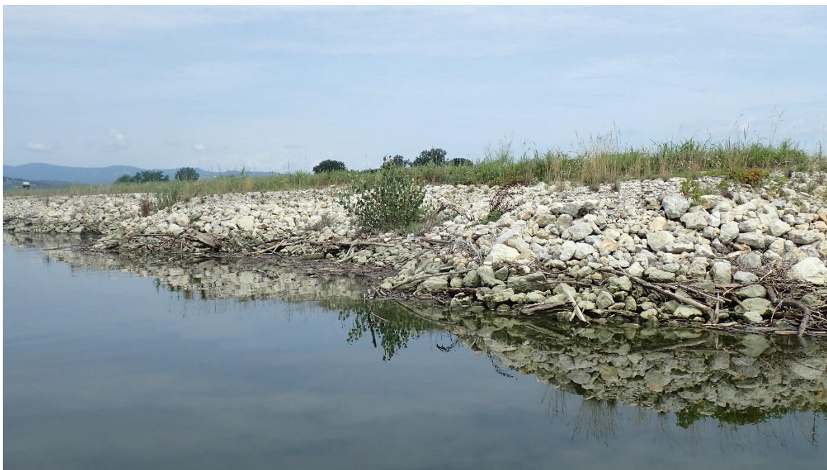
Sliki 12 in 13: Puste brežine brez vegetacije na spodnjem, dolvodnem odseku akumulacije.
