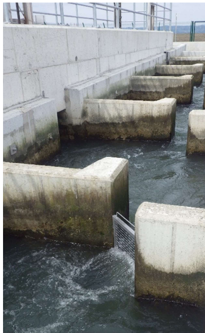
Slika 5: Namestitve vrše v tehničnem delu prehoda za vodne organizme (27.03.2019).
