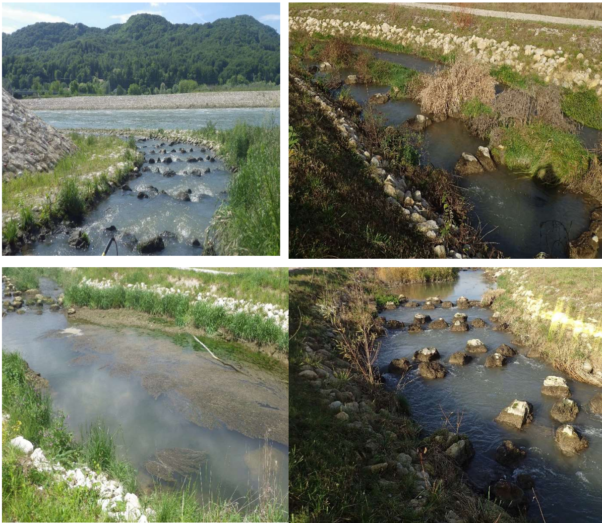
Slika 1: Značilne strukture prehoda za vodne organizme pri HE Brežice: izlivni odsek s pragovi (levo zgoraj), drstišče s prehodom (desno zgoraj), tolmun (levo spodaj), pragovi s tolmini (desno spodaj), maj in november 2019.
