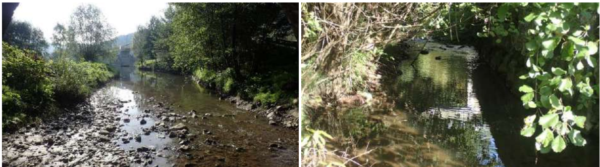
Slika 48: regulirani izlivni del (levo) in neregulirani del Podvinskega potoka (desno).
