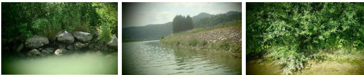
Slika 45: Kamnomet z grmovjem in drevesi (levo), kamnomet z nekaj trave (sredina) in sonaravna brežina (desno).
