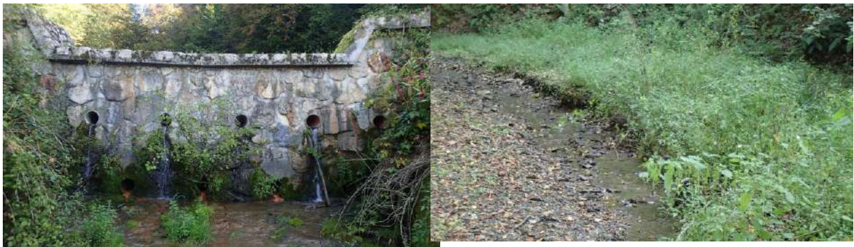
Slika 50: Prodna pregrada (levo) in neregulirani del Črnega potoka (desno).
