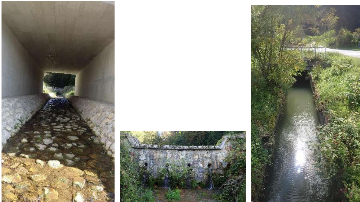
Slika 47: trda regulacija (levo) in prodna pregrada na Črnem potoku (sredina) ter betoniran Apneniški potok (desno).
