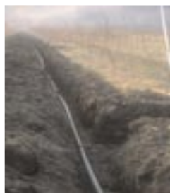
Slika 14: Izgradnja stabilnega oroševalnega sistema
