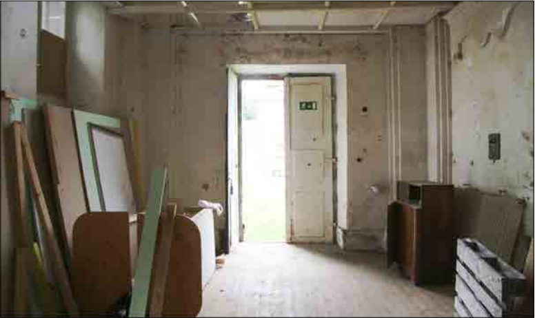
Foto 3,4 - vhod in okno v višini nadstropja na vzhodni steni
