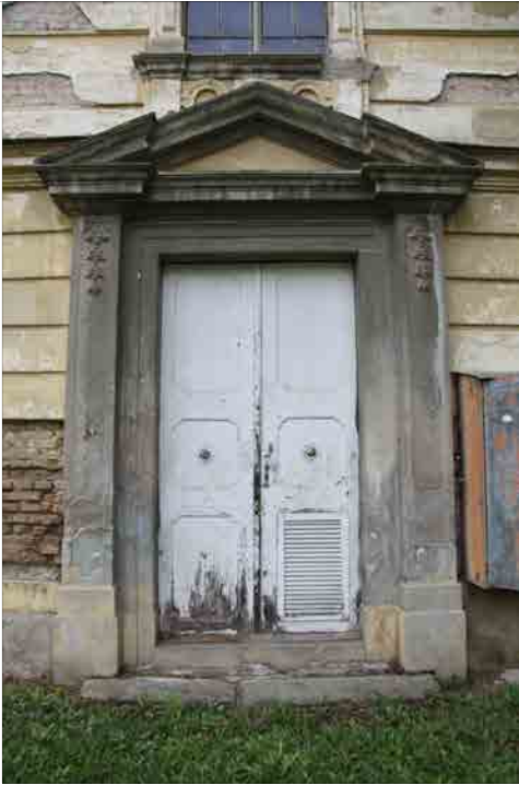
Foto 3 - vhodni portal v kapelo
