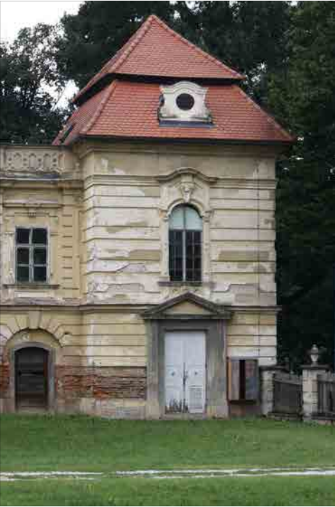
Foto 1 - vhod v nekdanjo zakristijo in kapelo
