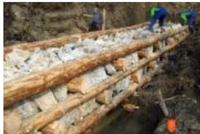
Gradnja kranjskih sten
