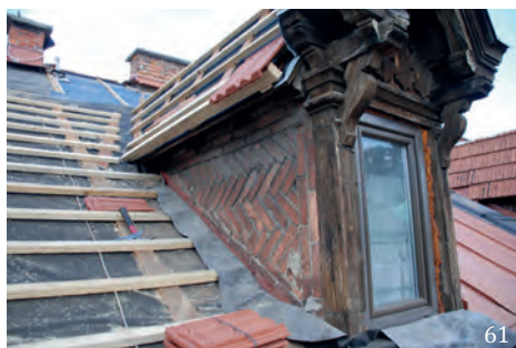
(60) Zamenjava povsem dotrajane strešne kritine je obenem priložnost za izvedbo sekundarne kritine in toplotne zaščite skladno s sodobnimi pravili stroke.
