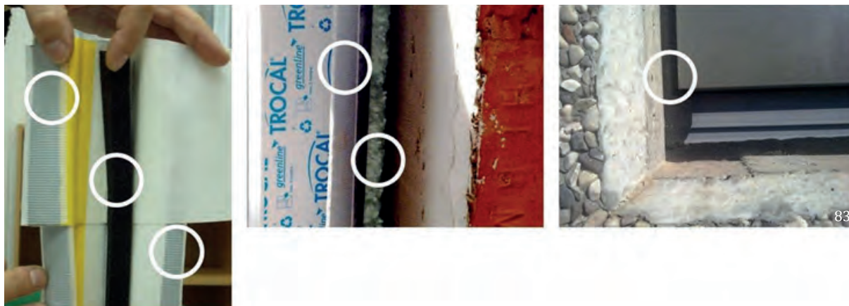
(83) Tesnjenje v treh ravneh lahko izvedemo s tri-, dvo- ali enokomponentnimi sistemi.
