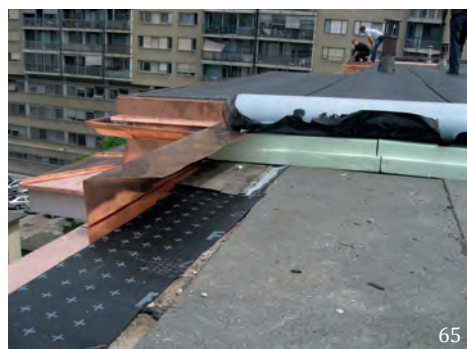
(64) Hidroizolacija ravne strehe z bitumenskimi varilnimi trakovi.
