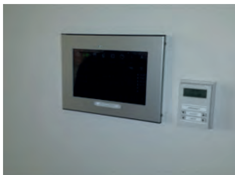
(88) Centralni nadzorni sistem
