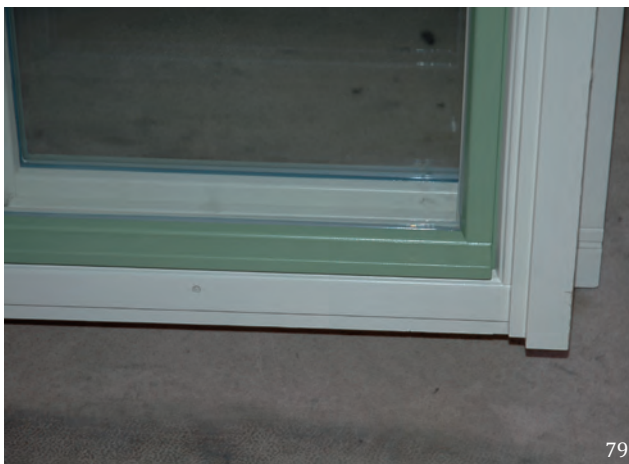
(79) Pri menjavi večjega števila oken je priporočljivo pred izdelavo vseh oken v celoti izvesti vzorčno okno.
