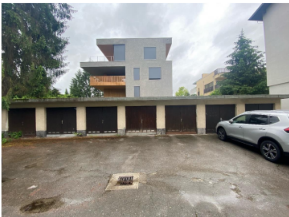
Slika 1: NIZ SEDMIH GARAŽ NA DVORIŠČU VEČSTANOVANJSKE STAVBE NA NASLOVU LEPI POT 14C, OD LEVE PROTI DESNI 2679-1500-1, 2679-1500-2, 2679-1500-3, 2679-1500-4, 2679-1500-5, 2679-1500-6 IN 2679-1500-7.
