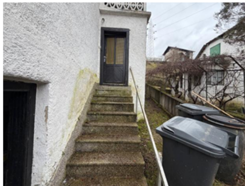
Pogled : stopnice v pritličje
