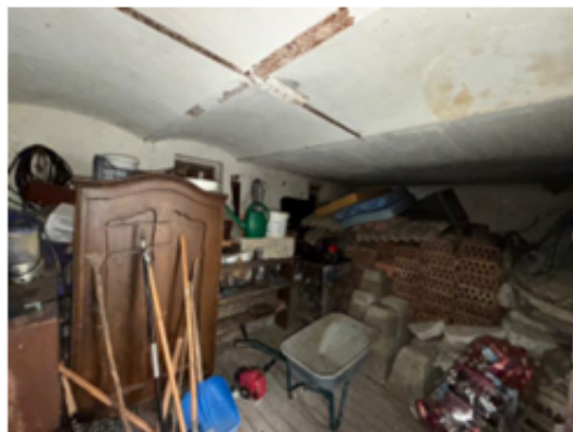
Pogled : štala, shramba
